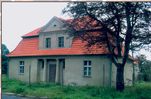
Budynek dawnej placówki polskiej straży celnej/granicznej w Henrykowie, 2006 r. [udostępione przez Narodowy Instytut Dziedzictwa Pracownię Terenową w Trzebinach]
